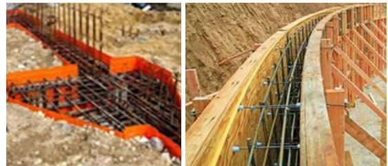
Hình 1. Hệ thống ván khuôn trong thi công móng và các tường chắn đất
